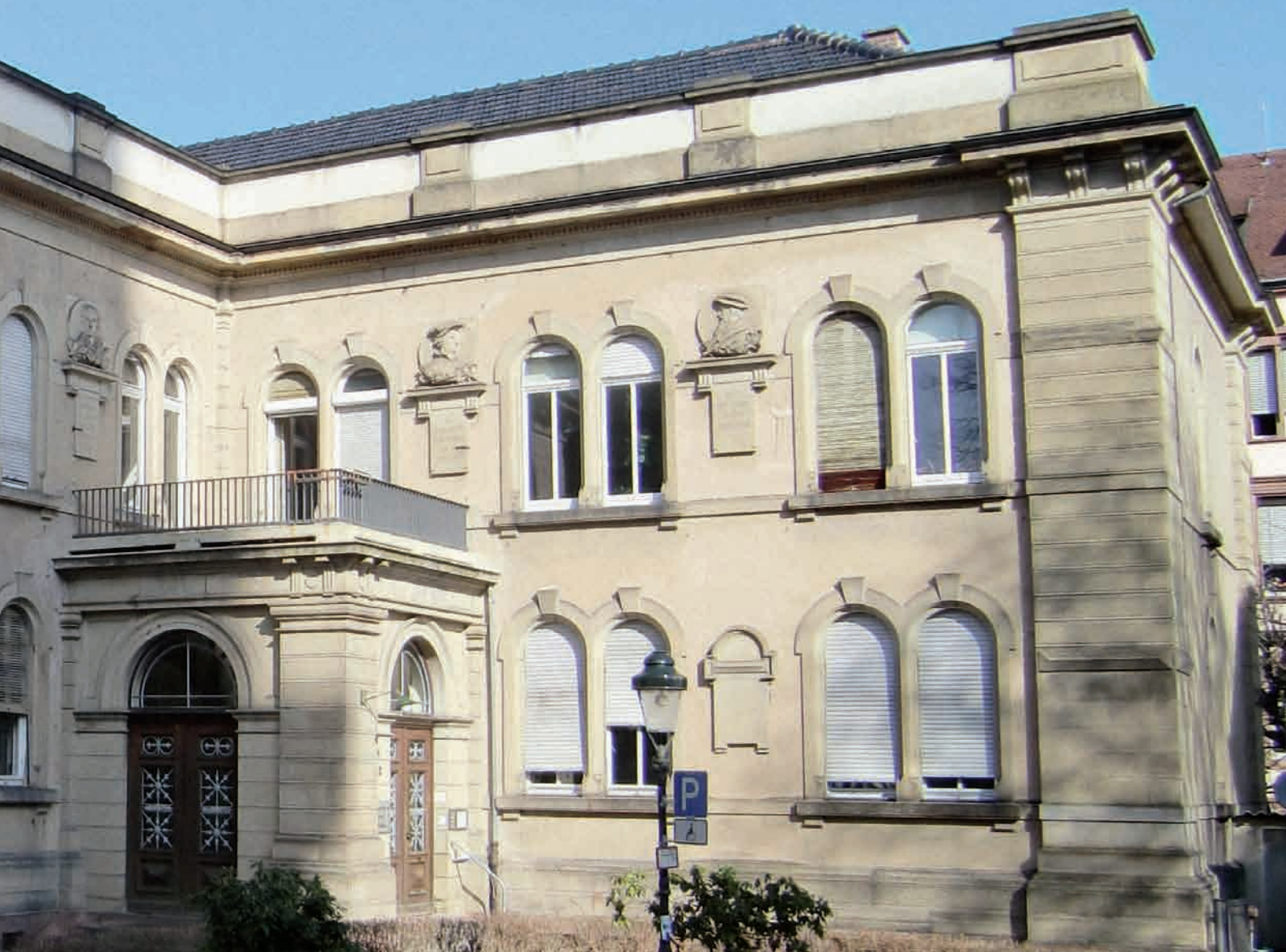
Dem Gemeindehaus Maienstraße 2 droht der Teilverkauf. Foto: Schmitt-henner, Freiburg 2012
